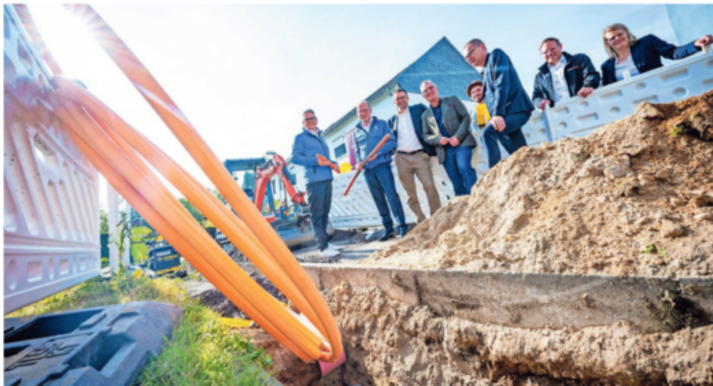
Netcologne hat bereits im Jahr 2023 mit dem Glasfaserausbau in Duisdorf begonnen.
