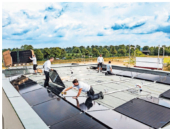
Das Team von EnergieGewinn auf dem Dach. Eine Solaranlage schafft mehr Unabhängigkeit, Planbarkeit und langfristige Kostensicherheit.
