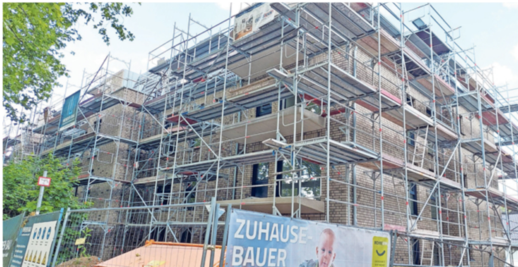
Neue Wohngebäude wie hier in Mehlem sind in manchen Stadtgebieten in Bonn ein seltener Anblick. Oft muss dafür zuerst ein bestehendes Gebäude abgerissen werden.
