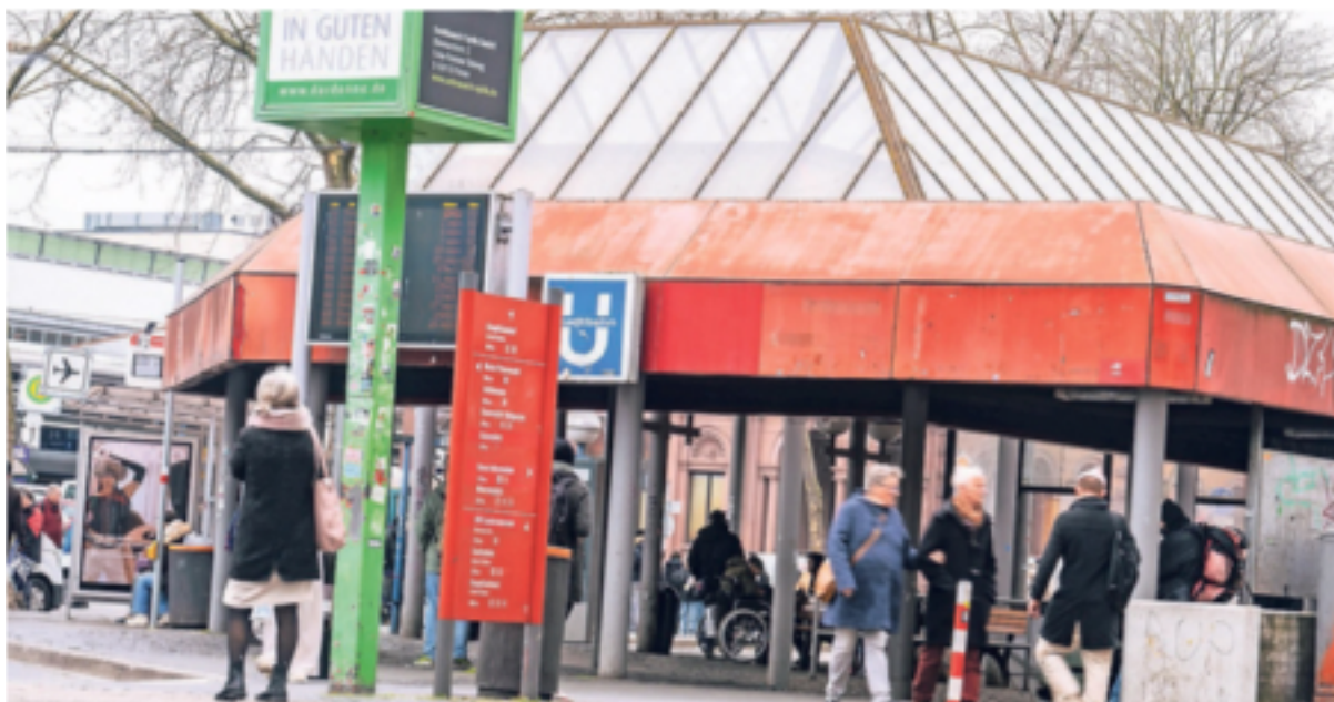
Der Busbahnhof wirkt an vielen Stellen verwahrlost. Die Planungen für einen Neubau sind im vollen Gange. FOTO: WESTHOFF
